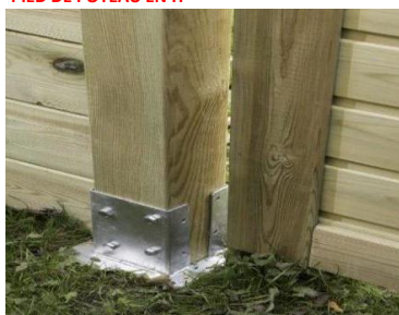
PIED DE POTEAU ACIER GALVANISE TYPE H
